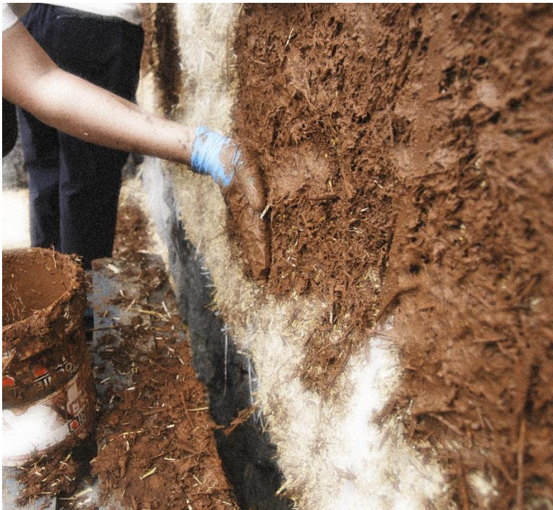
Ilustración 5 Revoques de barro
